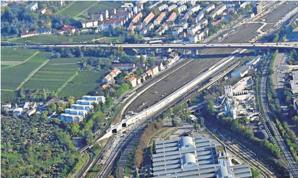
Auf der Interregio-Kurve (Mitte) bei Untertürkheim sind oft Güterzüge unterwegs, und am Sonntag auch die Waldbahn. Oben im Bild die lang gestreckte B-14-Brücke. Foto: Armin Kilgus (Bahn)
